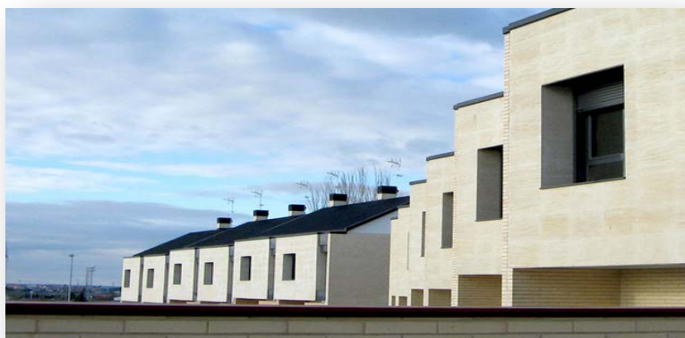
Obra nueva realizada sobre una superficie, distribuida en 4 plantas, próximo al Campo del Salamanca.
