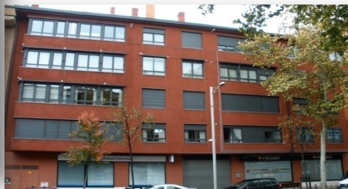
Obra de rehabilitación del antiguo edificio de Oficinas de Telefónica.
