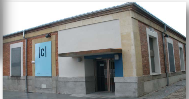
Centro de creación cultural situado en la, antigua cárcel de Segovia.
