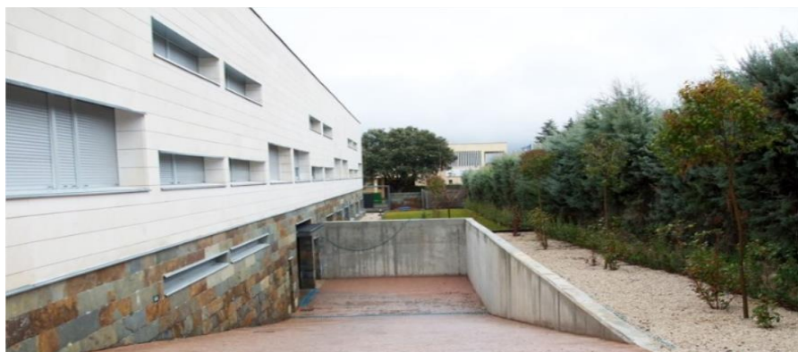
Obra nueva realizada en Brunete (Madrid).
