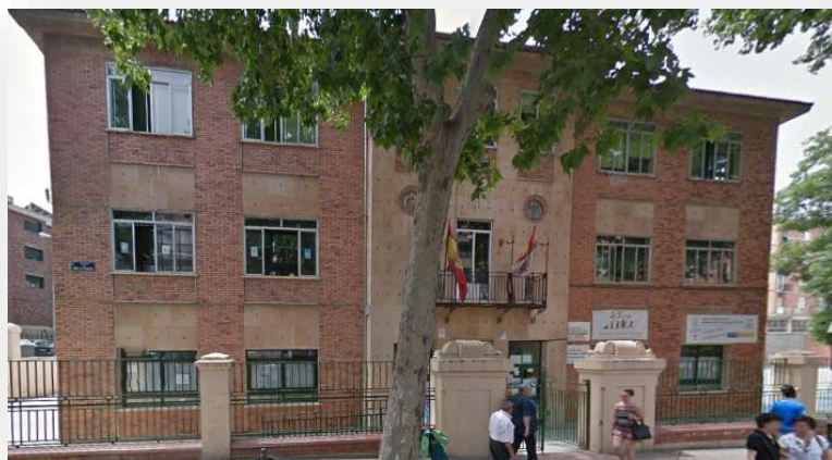
Rehabilitación del colegio, sustituyendo la carpintería antigua por una nueva, y la creación de un nuevo gimnasio.
